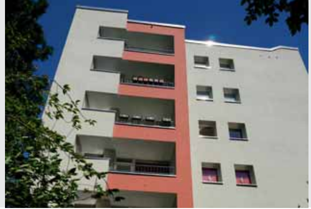
Rudow, Neuköllner Straße, Modernisierung
