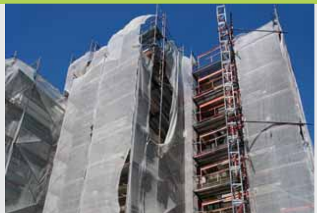
Rudow, Alt-Rudow 8, Modernisierung
