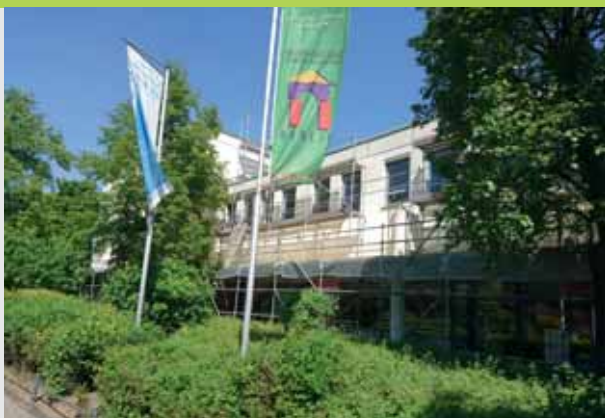
Britz, Britzer Damm, Gewerbe Modernisierung
