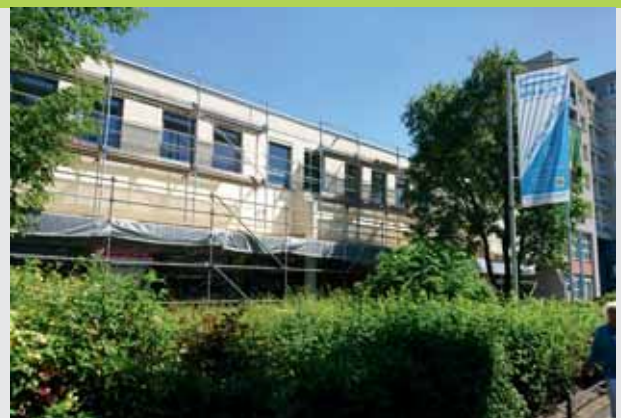
Britz, Britzer Damm, Gewerbe Modernisierung
