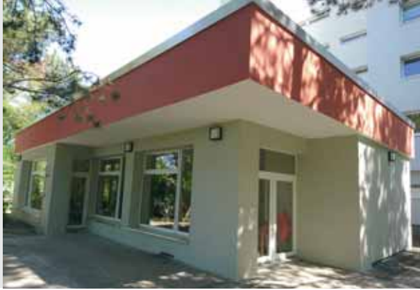
Rudow, Neuköllner Straße, Modernisierung
