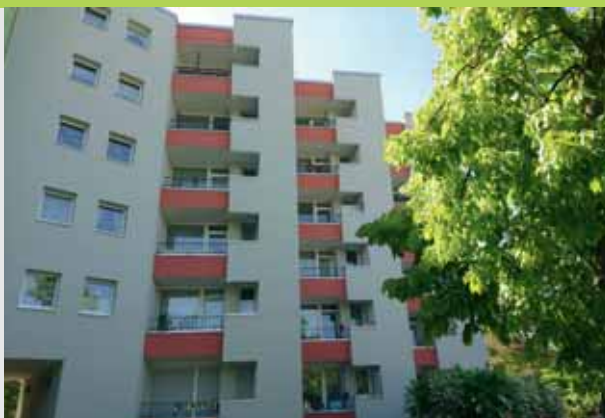
Rudow, Neuköllner Straße, Modernisierung
